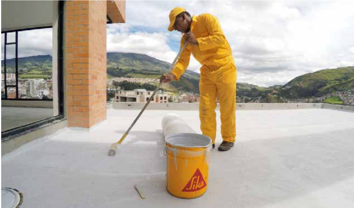
En el mercado se pueden encontrar dos tipos de impermeabilizantes como los prefabricados y las membranas líquidas aplicadas.
