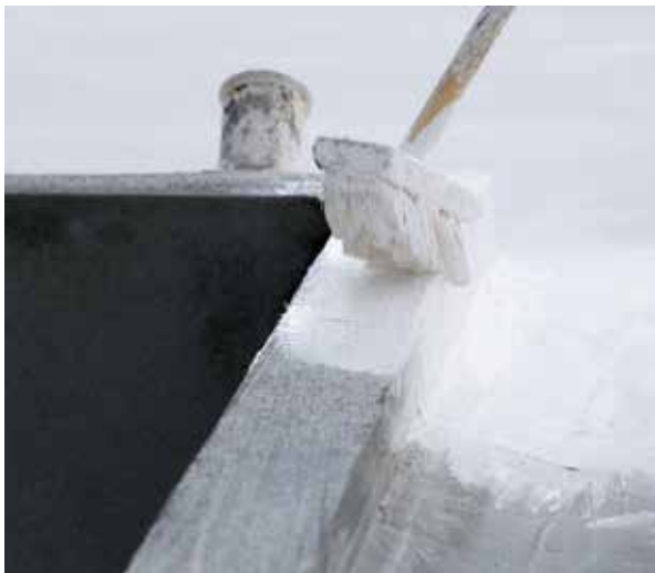
Al aplicar cualquier sistema de impermeabilización, sea líquido o preformado se debe realizar un trabajo de preparación de la superficie.
