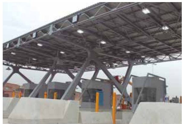
Zona de peaje ubicada antes de ingresar al túnel que tiene 1.8 km de extensión.
