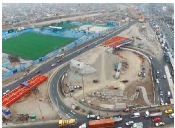
Construcción del viaducto 6 en el óvalo Caquetá.
