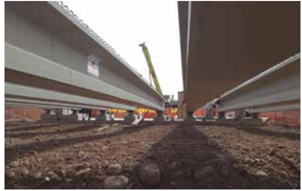
Para este proyecto se suministraron 300 aisladores Freyssinet tipo HDRB, distribuidos en tres viaductos enterrados.
