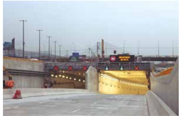
El túnel de 27 m de ancho y 6 m de alto cuenta con 6 carriles, 3 en cada sentido. Éste ha sido implementado con un sistema de monitoreo de tráfico en tiempo real.
