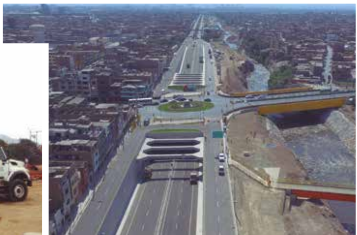
Paso a desnivel Morales Duárez, ubicado al costado de la Av. Universitaria. La estructura es de concreto y vigas prefabricas en concreto pretensado.
